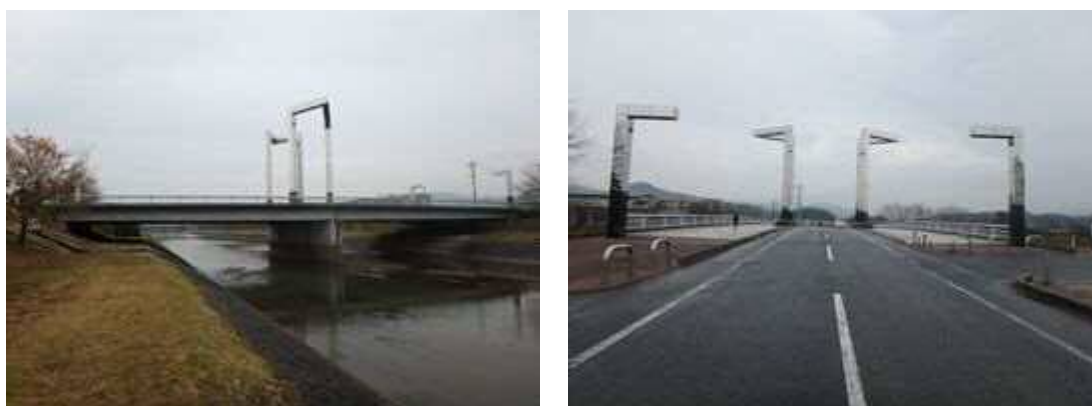
さくら橋（PC橋） 橋長 65.200m 1994年完成
